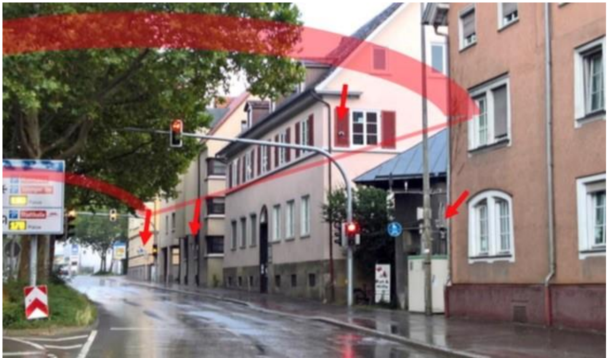
Bild Nr. 3 Eigene Aufnahme Verdeutlicht die Gesamtsituation der Nichtbeachtung der RL- Forderung nach freiem Luftstrom.
